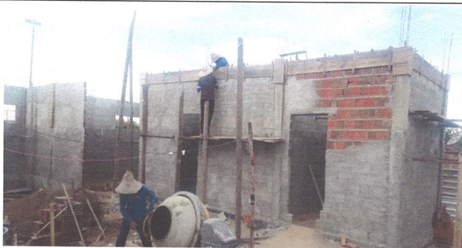
LEVANTE DE ALVENARIA DE BLOCO CERÂMICO
