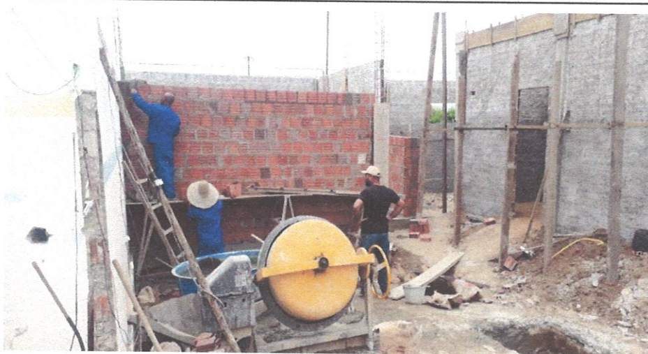
LEVANTE DE ALVENARIA DE BLOCO CERÂMICO
