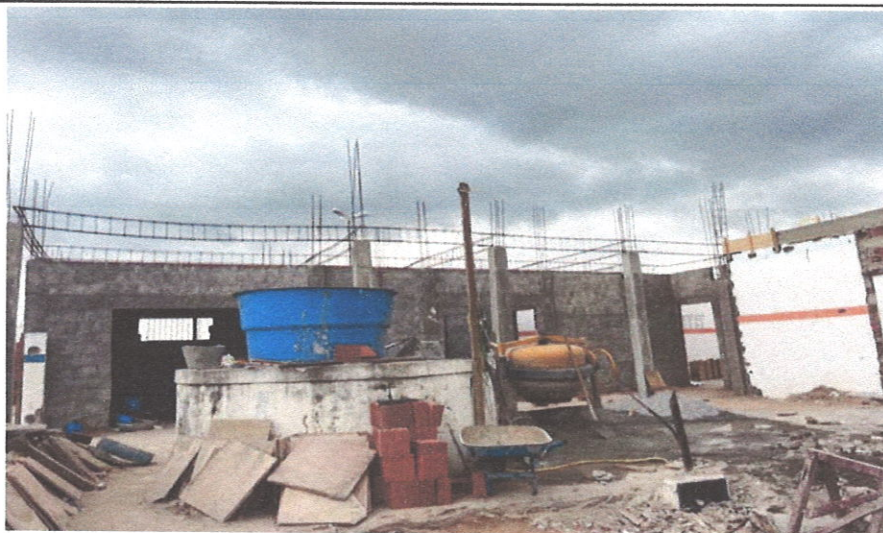
CONCRETAGEM DE VIGAS
